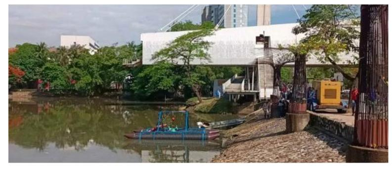
más de 28 mil metros cúbicos de sedimentos, de los 61 mil metros cúbicos contemplados; con una actualización en la batimetría de 3 metros de profundidad, cuando previo a los trabajos en el cuerpo de agua la profundidad era de tan solo 60 centímetros debido al fuerte asolvamiento.
